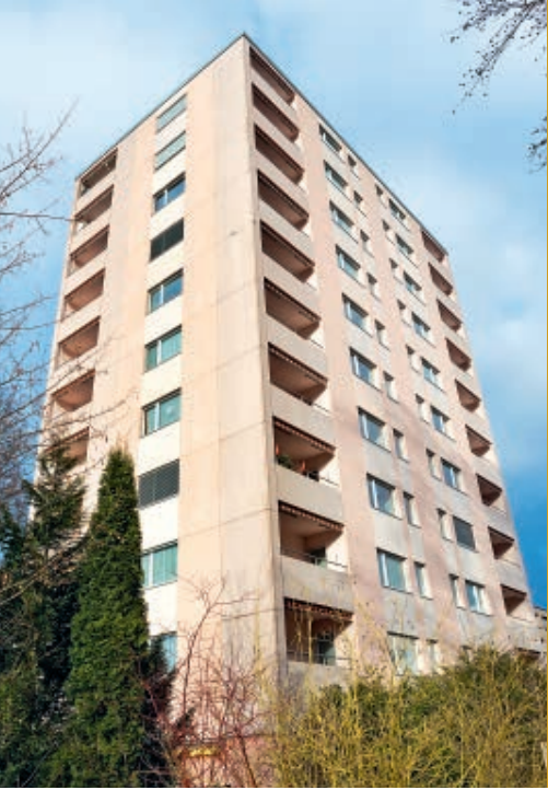
Kasernenstrasse 89a (Baujahr 1970)
