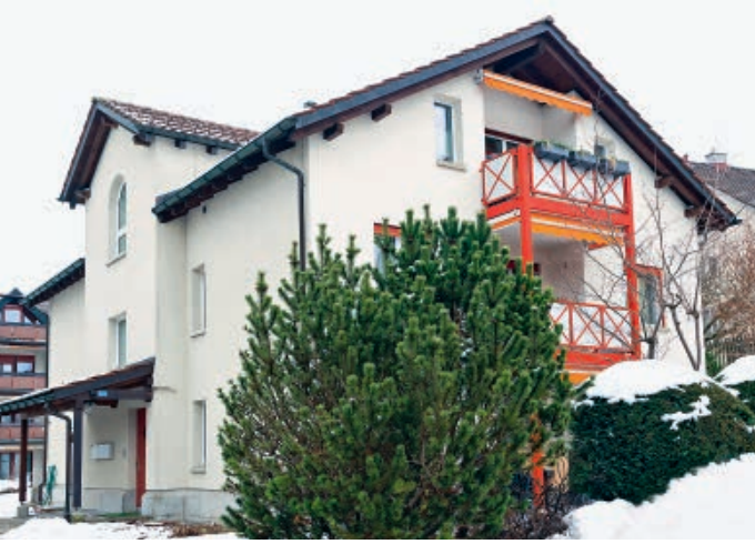
Kasernenstrasse 82a (Baujahr 1988)
